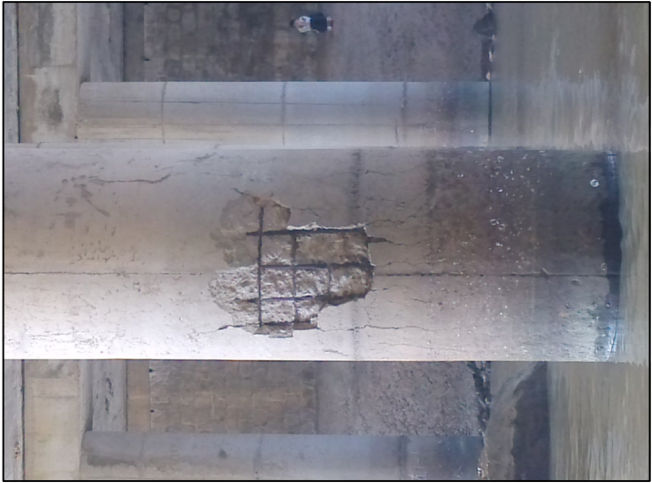
右3-1墩混凝土开裂、脱落且钢筋外露且锈蚀严重
