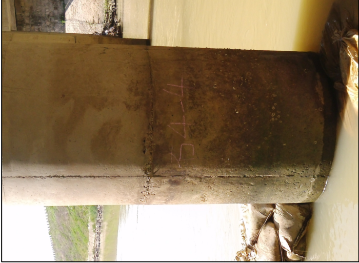
右4-4墩表面混凝土存在明显腐蚀
