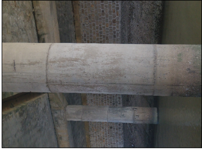
右3-2墩存在明显纵向裂缝
