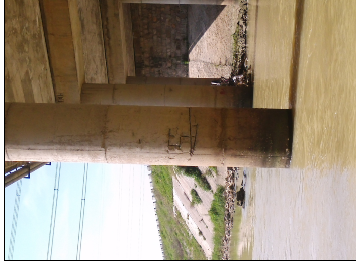
右3-4墩混凝土开裂、脱落且钢筋外露且锈蚀严重
