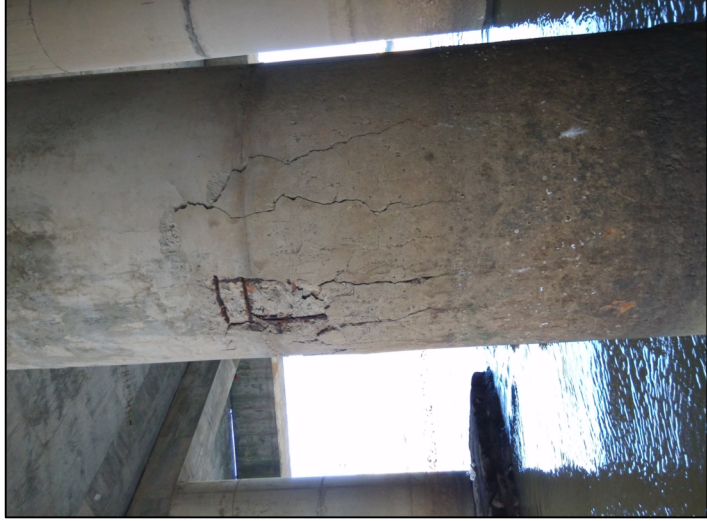
右4-1墩存在明显纵向裂缝、钢筋外露且锈蚀严重
