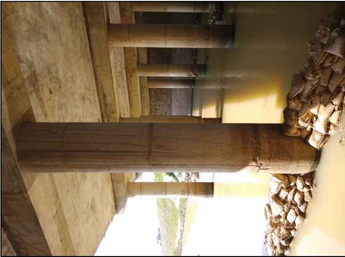
右4-3墩混凝土开裂、脱落
