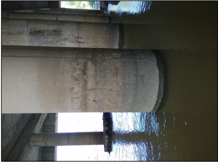
右4-2墩表面混凝土剥落
