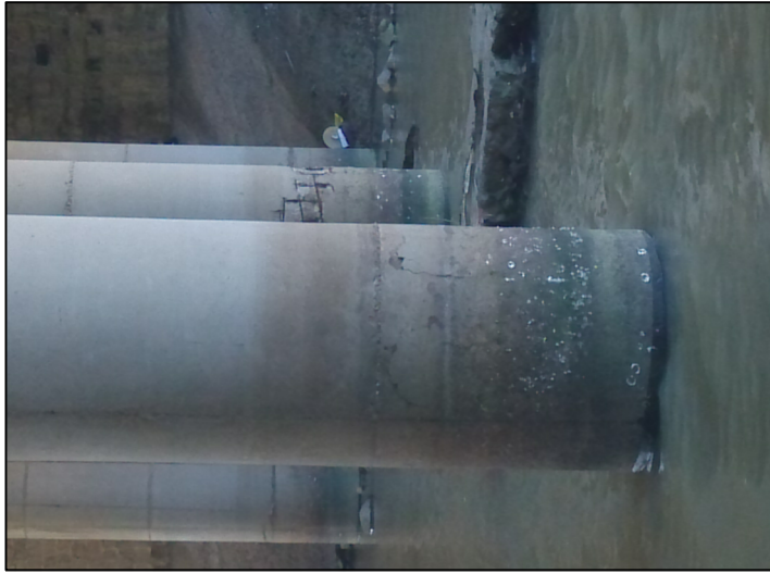
右3-3墩存在明显纵向裂缝
